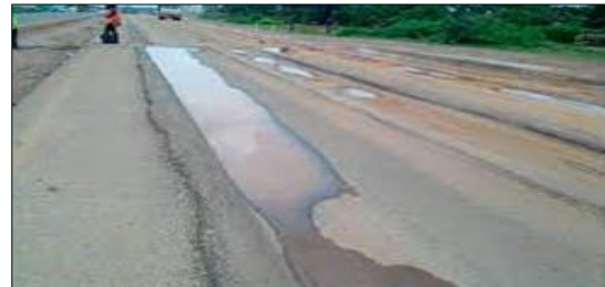
شكل 2. أضرار التخدد على الطرق الاسفلتية.
